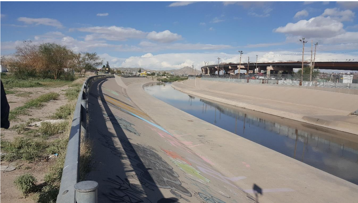
Figura 11. Fotografía Canal Chamizal, cuyo objetivo es estar revestido de concreto para mantener un límite fijo entre los dos países
