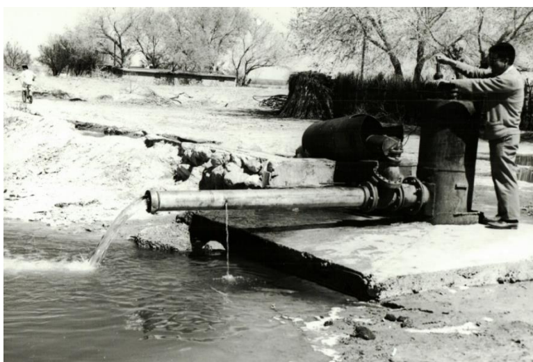
Figura 18. Fotografía del pozo y canal recolector en San Agustín
