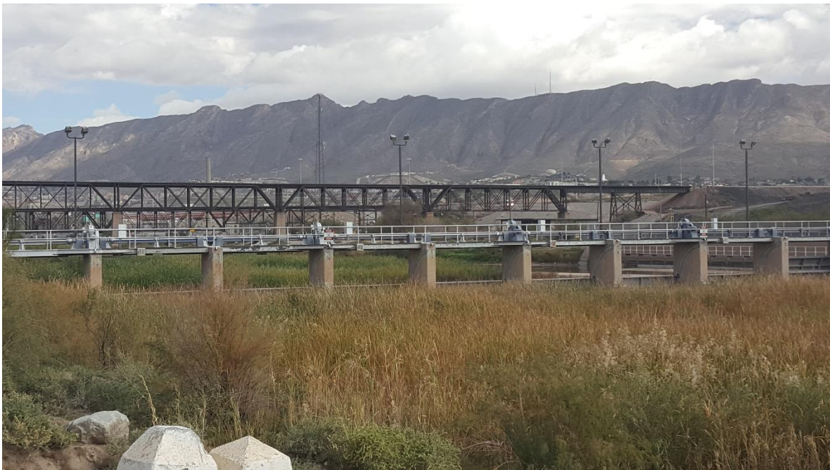
Figura 9. Fotografía de la Presa Derivadora Internacional e inicio de la Acequia Madre
